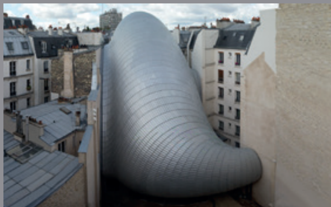
FONDATION JÉROME SEYDOUX-PATHÉ Paris, Frankreich RENZO PIANO BUILDING WORKSHOP
