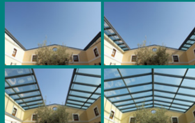
ÖFFENBARES STAHL-GLASDACH Projekt: Adler Thermae, Bagno Vignoni (IT)
