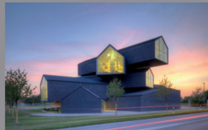
VITRAHAUS, SHOWROOM Weil am Rhein, Deutschland HERZOG & DE MEURON
