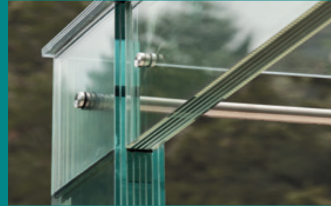
GANZGLASKONSTRUKTION Projekt: Parkhotel Vitznau, Luzern (CH)
